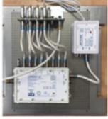
F-F Quick Patchkabel 50cm (z.B. für Potentialausgleich)
