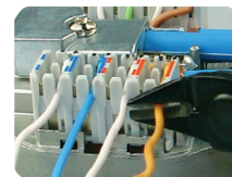
Abb.: Überstehende Adern abschneiden
